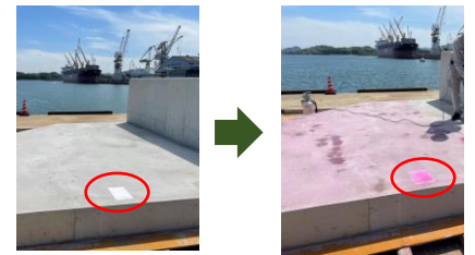
塗布量確認シート施工状況
