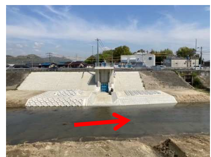
吐出樋門（瀬戸川）
