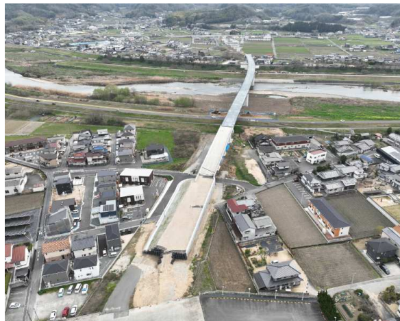
施工状況（福山市駅家町）
