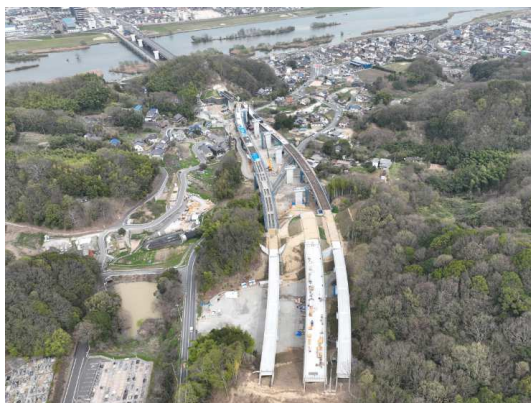
施工状況（草戸町周辺）
