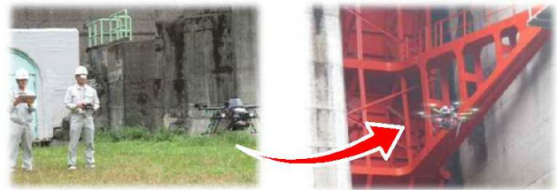
ドローンを活用した施設点検
