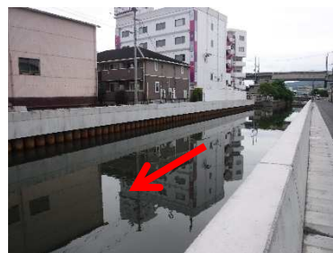
中流域工事（福山市引野町）
