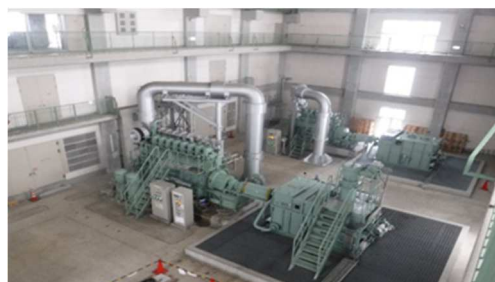
ポンプ増設工事（手城川排水機場内）
