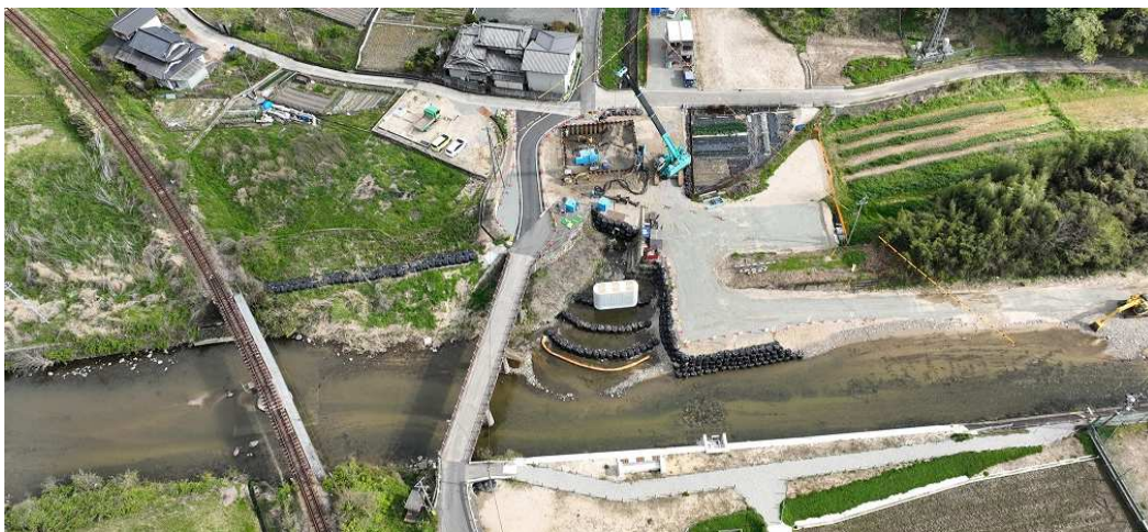
（新）僧殿橋右岸橋台工事
