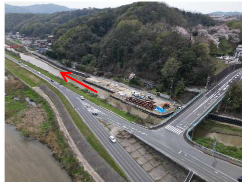
用水管渠敷設工事
