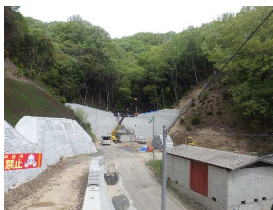
観音谷川 砂防激甚災害対策特別緊急工事 (府中市広谷町 施工中)
