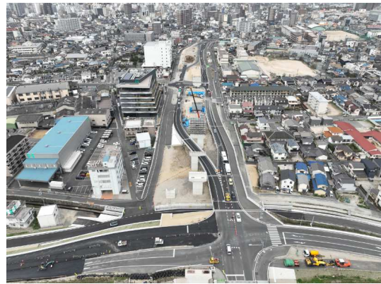
施工状況（草戸町周辺）
