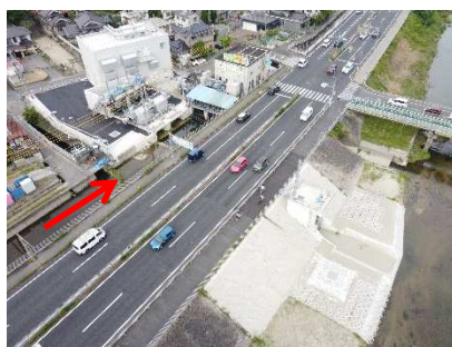
福川排水機場（福山市神島町）
