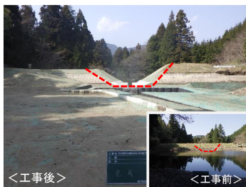
ため池廃止工事（広島市）
