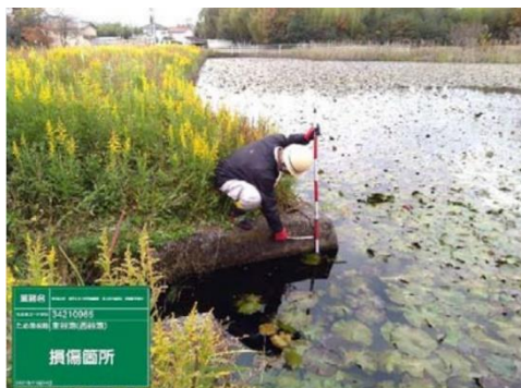
劣化診断の実施状況（東広島市）
