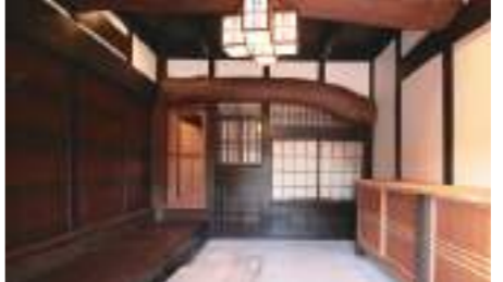
梁や天井、舞良戸など既存のまま生かし、正面に新たな通路を設けた。下駄箱・沓脱石も新たに設置した。
