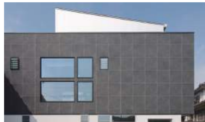
子世帯外観:2階に大きな窓を設け吹抜から光を取り入れる。上部の三角屋根はロフト部分。
