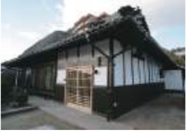
納屋が接合されていた部分の屋根を新たに設置し、既存の風合いを損なわないような形状とした。
