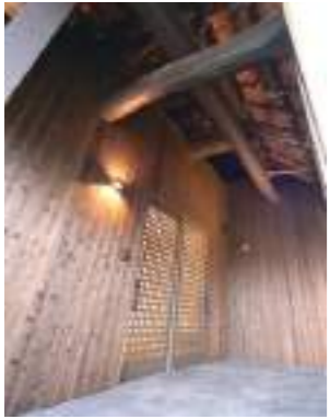
土間から茅が見えるノスタルジー空間。屋根裏を開放しておくことで茅の痛みも軽減。
