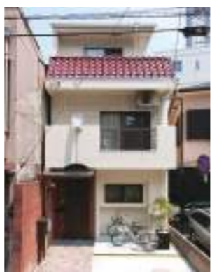
1階道路側の部屋を減築して駐車場を確保し、明るくなった外観。
