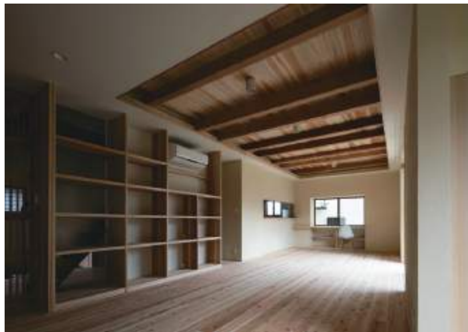
既存梁を利用した天井、浮造りの無垢フローリング、珪藻土の壁で構成。造作棚のガラス越しに階段が見える。
