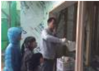
家族全員での梁、柱、天井の塗装工事。
