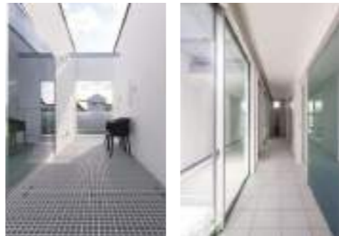
通り庭上部のバルコニー。光や風を通すため床はグレーチングを利用し、手摺で道路からの視線を遮っている。 通り庭に面して配置した片廊下式のホール。通り庭から光や風を受け取る縁側のような存在。
