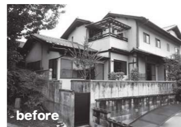
改修前 里道側からの全景。
