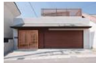
親世帯外観:交通量が増加したので、1階はオーバースライダー、2階は縦格子でプライバシーを確保した。
