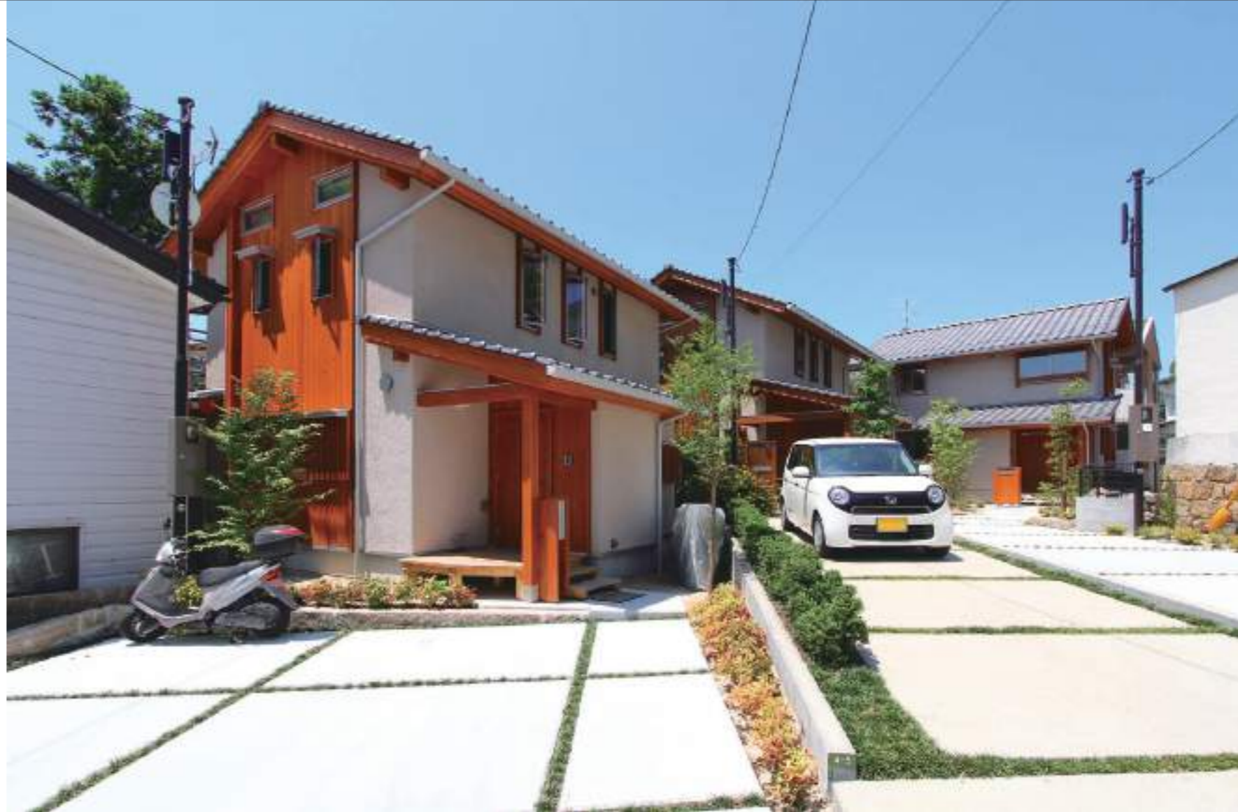
西国街道に近接した歴史ある街に新しい表情をつくる／三敷地の舗装・植栽を統一した広場のようアプローチ空間と、軒の深い瓦屋根の連なる雁行した配置計画。
