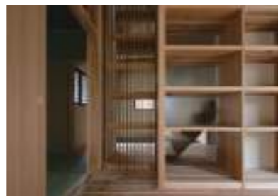
必要に応じて格子の引き戸を開閉することで空気の流れを制御し、温熱環境をコントロール。
