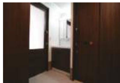
車いすが転回できない洗面室からホールへ洗面台を移動。帰宅時の動線でもあり、手洗いうがいも習慣に。
