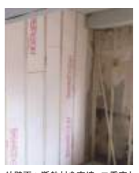
外壁面へ断熱材を充填。二重窓と併せて外気温に左右されず省エネ性向上にも一役。
