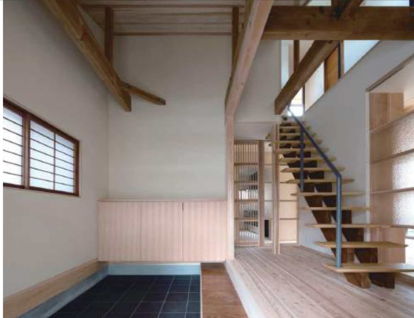
玄関の天井を撤去して吹抜の階段ホールとし、それぞれが独立していた各室を階段を中心に繋ぐ。
