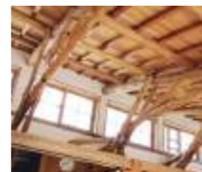
レモンド建築の特徴であるシザーストラスを再現。
