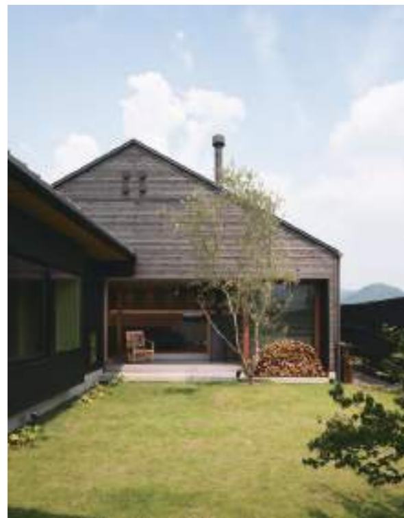
オリーブや煙突が印象的なインナーテラスの外観。冬には深く日が差し込み、陽の高い夏には深い軒が影を作る。
