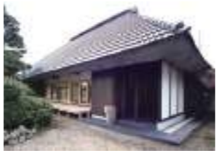
外壁は焼杉と白しっくい。再利用した手水鉢を玄関前に配置。茅を銅板で囲う趣きのある屋根はそのまま。
