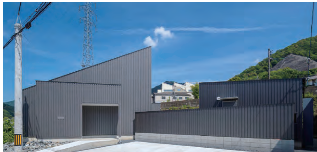
塀の向こう側に中庭があり、道路からは見えなくなっている。外壁を同じ材料にして、2棟に分かれていても一つの住宅と分かるようにした。
