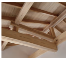
構造材には地元産の杉・松を使い大工による手刻みで仕上げ、力強い木組みをダイナミックにあらわした。
