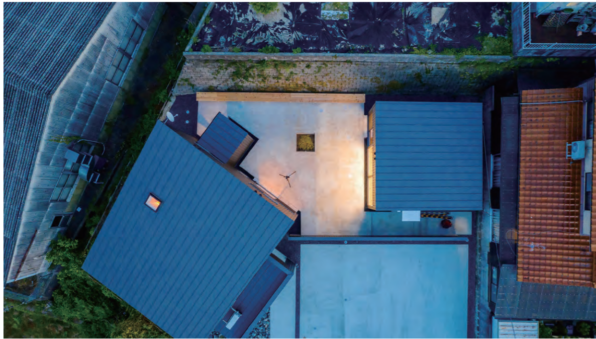
2棟に挟まれた中庭。中央に植えたカツラの木が成長して木陰が出来るのが楽しみである。
