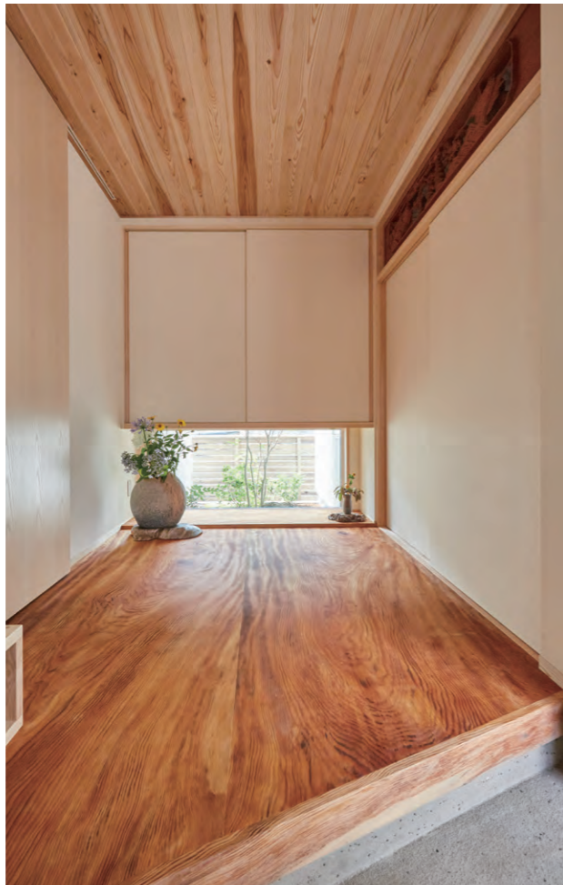
建替え前の旧宅の広縁に使われていた肥松の一枚板を玄関の床に再利用。思い出の継承を図った。
