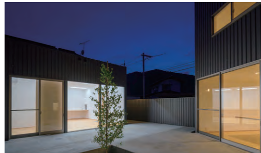
中庭とリビングは同じ高さの床で連続感が感じられるようにした。外壁には丸い輪が取り付けられてあり、日よけ対策でテント地を張る事も出来る。
