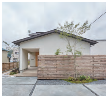
オフホワイトのガルバリウム鋼板の外壁と木崩の外観。世代を問わず似合うようシンプルにまとめた。
