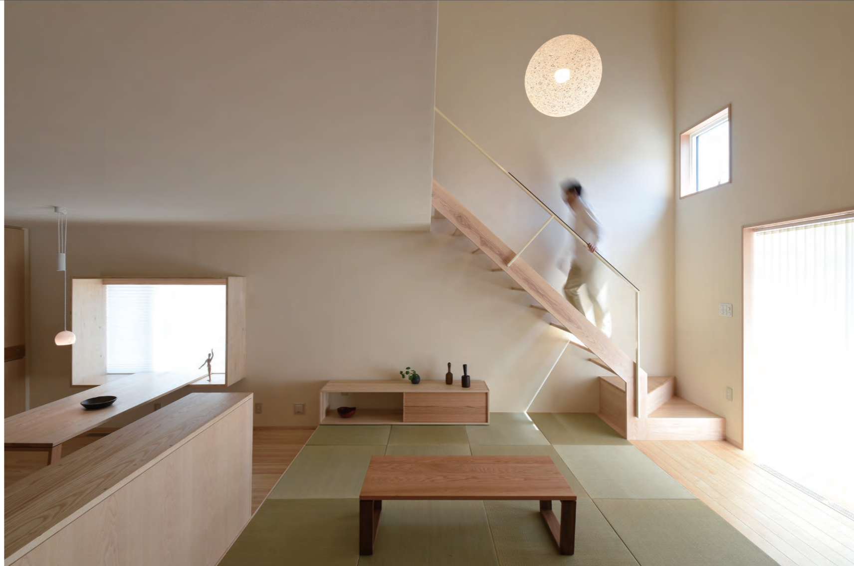
階段の側板には家具用の木材(アッシュ材)を採用し、曲がり部の接合に家具用の金物を使用した。
