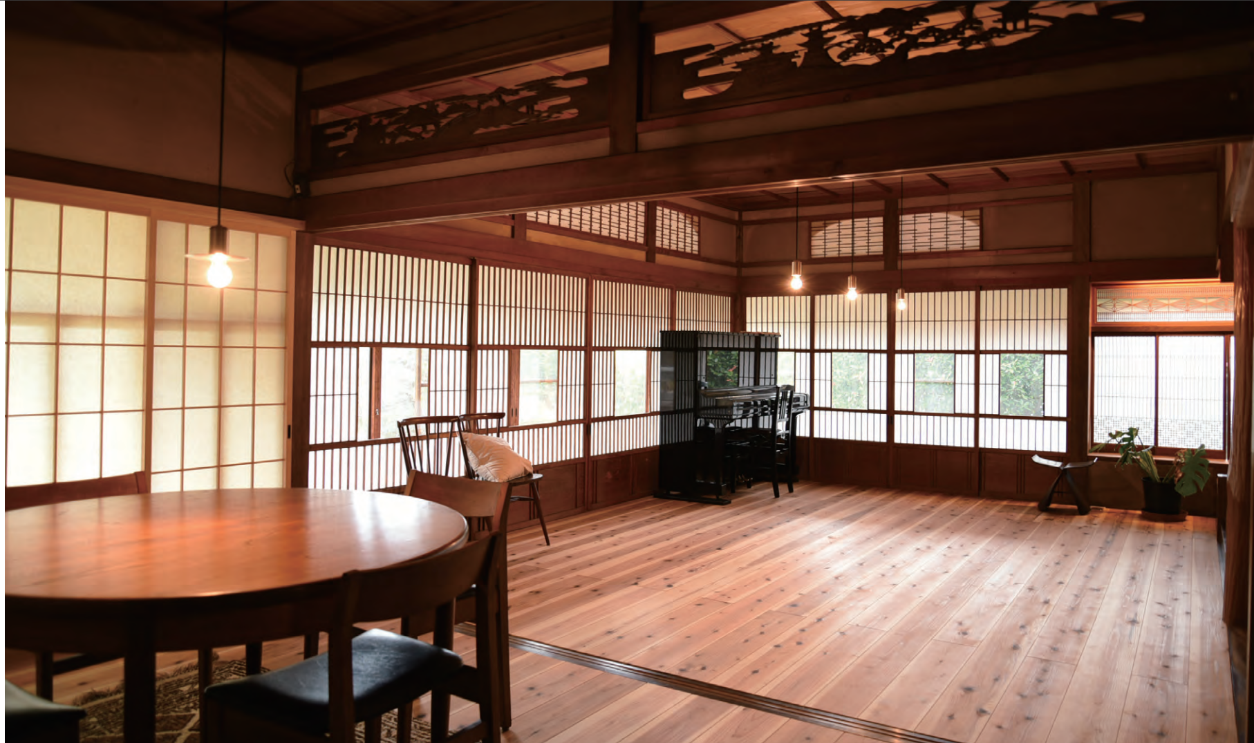
床下に断熱材を施し、無垢のフローリングに差し替えた。新設した障子や床は既存の風合いに馴染むよう仕上げた。
