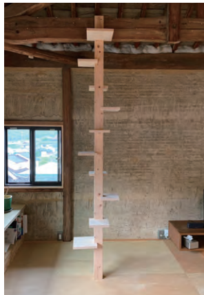
梁に繋がるキャットタワーを設け、ペットの猫にとっても楽しく暮らしやすい家づくりを行った。
