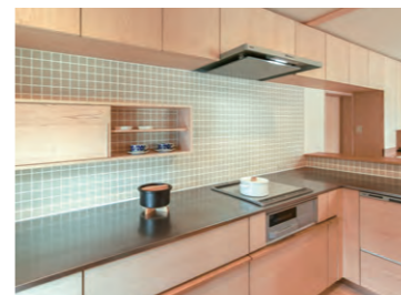
既製品キッチンの前板を取り外し、家具の材料で製作した扉に交換することで家具との調和を図る。
