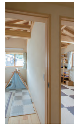
木組みの見える天井とし、下部に間仕切り壁を設けた子供室。
