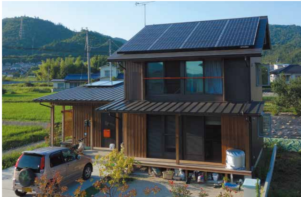
昼光利用・日射熱利用・自然風利用・日射遮蔽がしっかりと計画された外観。 太陽の熱や光も最大限利用する備えもあり、夏涼しく冬暖かい省エネ性能に優れた住まいである。
