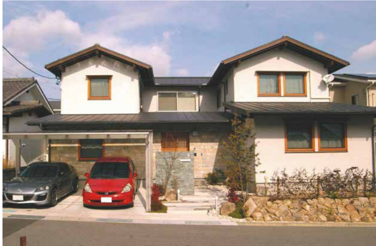
外形は中庭を囲うようにコの字型の外観。塗り壁と木製サッシが趣を添えている。
