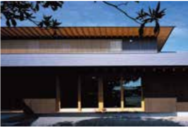
南面ファサード。手前の木製建具はリビングの框戸。戸袋に引込むことで開口幅3.400の大開口となり庭とのつながりを強くする。
