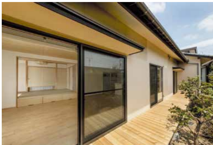
南側開口部:光と風を取り入れるためにLDKを日当たりの良い南側に配置した。窓に複層ガラスを採用し、省エネ効果を高めた。
