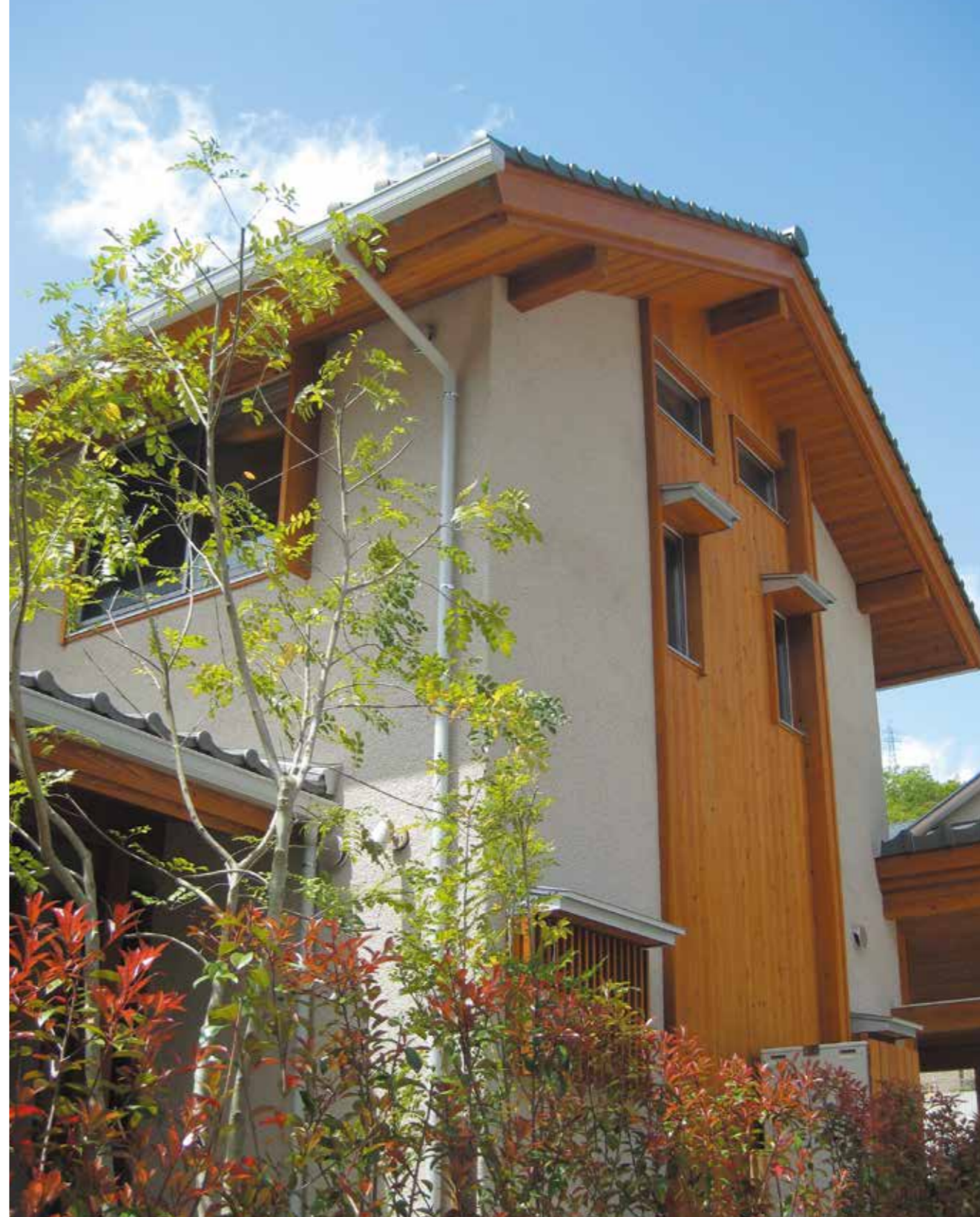
2階建て部分裏面は隣棟との視線の交錯を少なくするため最小限の窓の大きさとししました。手前のレッドロビンが生垣のシマトネリコは1階部分の視線を遮りながらも、互いの住まいから見て楽しむことのできる植栽です。軒を長くし建物の耐久性向上に配慮しています。
