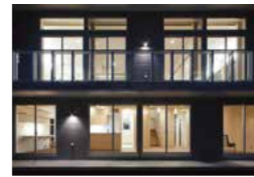
南側外観 夜景 南面いっぱい開口部を設け、通風・採光を積極的に取り込む。
