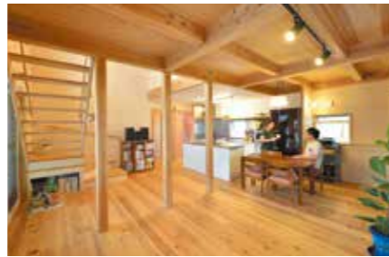
2階へ続く吹き抜けの階段は窓から多くの光を取り込めるように設計。1階の掃き出し窓にはルーバー雨戸を設置し、夏は日射を遮蔽しながら室内に風を通す。冬は2階の窓からたくさんの太陽光を取り込み温かな温熱環境を実現する。
