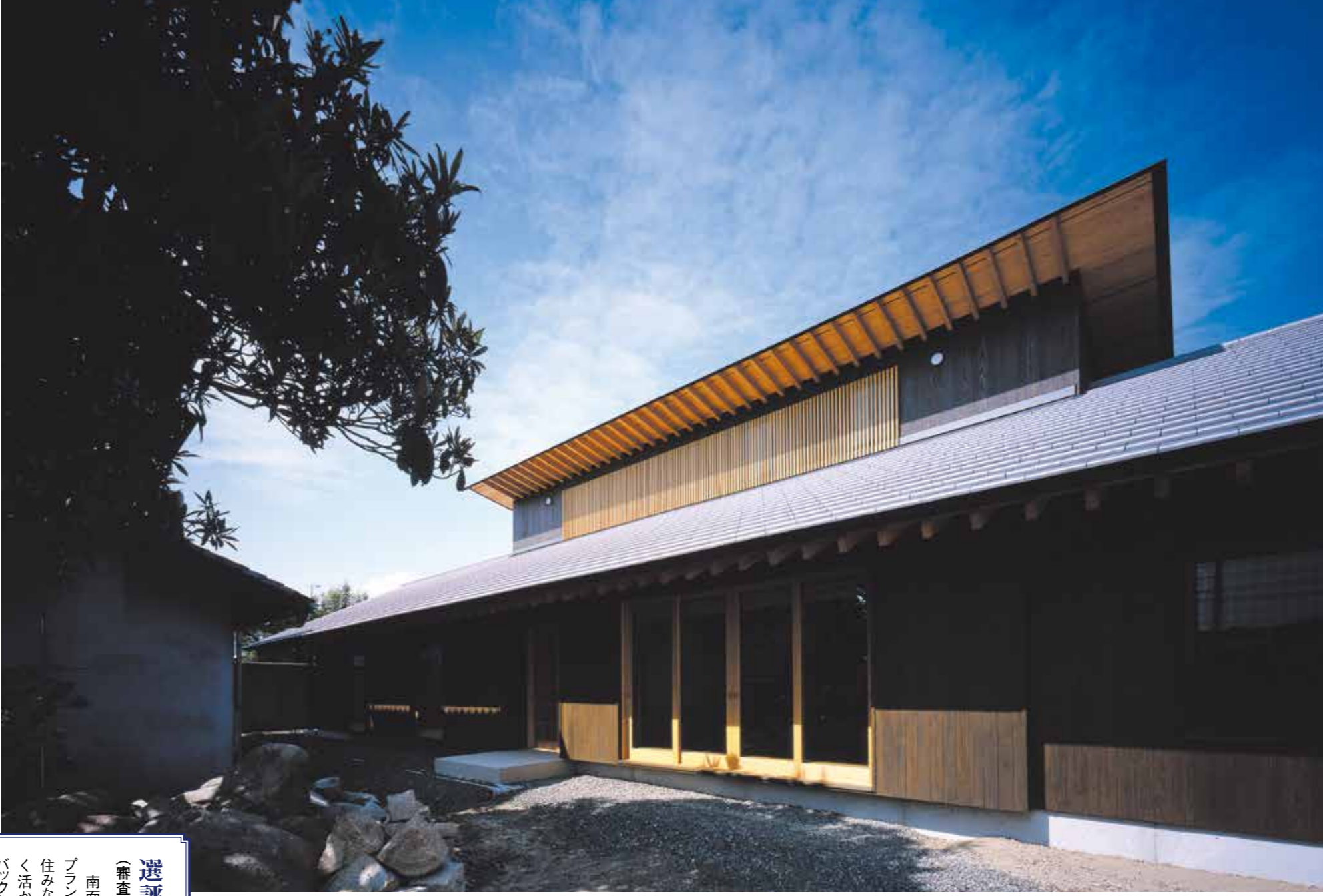
化粧垂木・いぶし瓦・窓格子・外壁板張りなどの連続性と深い軒の水平性が強調される南面ファサード。外壁と軒裏の仕上げは杉板張り
