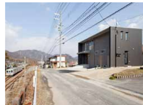
北側外観 2階から電車が見える。
