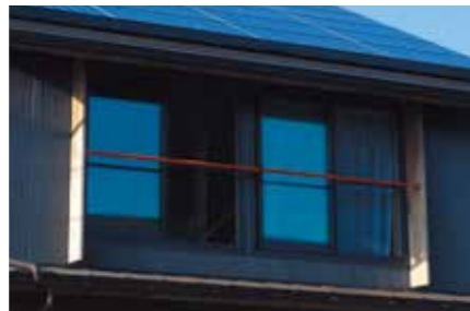
縦庇により西日を遮蔽。左右の縦庇はウィンドキャッチャーの役割も兼ねる。
