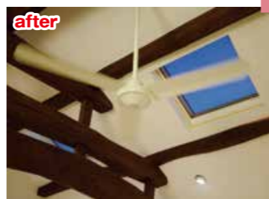
立派な梁天窓で明かり取り
