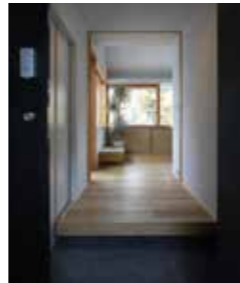
玄関を見る。土間床はスミモタル仕上げ。室内床は無垢タモ材フローリング t=15。室内壁は珪藻土左官塗り。
