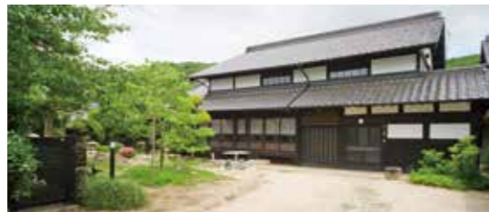
外観/壁面を白塗り木部を墨色にし、窓廻り・種も合わせて墨色に統一。建築当初の姿を復元した。
