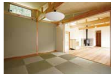
大きな梁は地元産の松材を使用。高窓から山の緑も楽しめる。
