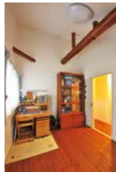
耐震構造上抜けない梁をいかけた子供部屋。
