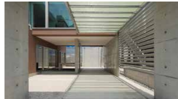
車庫入口より庭の全景／車庫の屋根はガラス+ファイバーグレーチング。
