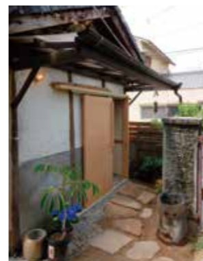
アプローチ。漆喰壁は削って白くする。
