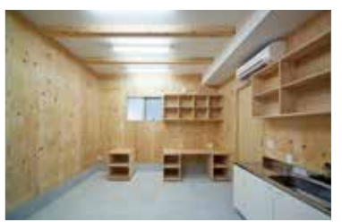
インテリアは針葉樹合板とし家具も針葉樹合板を現場加工し小口テープを張る工夫を施し味わいのある空間を低コストで実現。
