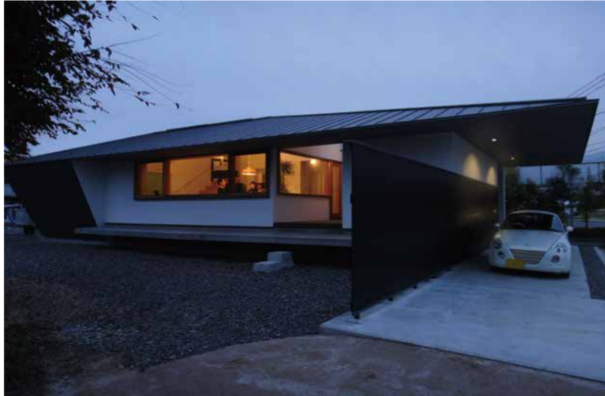
敷地東側角より外観を見る。屋根はガリバリウム鋼板 タテハゼ葺き。庇の出は 2700mm。ヴォリュームを抑えた断面計画により、庭側から見ると平屋の様な大屋根の建物。大屋根を生かした駐車スペースは、雨の日でも濡れずに便利。
