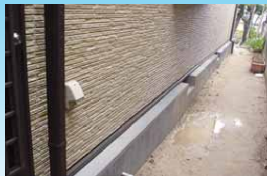
基礎補強（完成）
