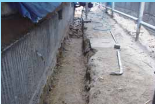
基礎補強（掘方）
