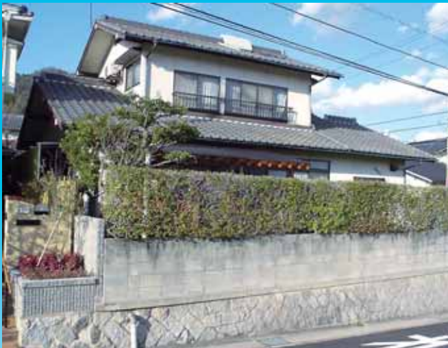
既存家屋（外観）
