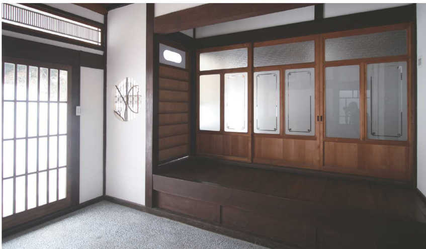
左官、塗装を塗り替えている。既存建具、下地窓などの状態の良いものは一部修繕し再利用することで、既存の建具が綺麗に映る。
