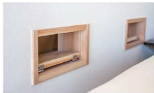
暖気を循環させるため、1階天井から2階寝室壁へ抜ける小窓を計画。施主のアイデアが随所に活かされている。
