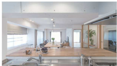
壁と天井はスケルトンにして新設、梁はコンクリートを塗装して新築には出せない荒さと素材感を出した。
