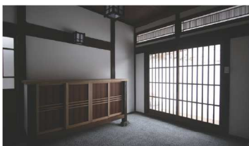
洗い出し仕上げの土間が味わいのある玄関を演出。下駄箱や玄関建具も職人の造作である。
