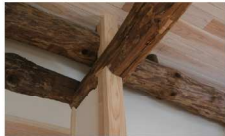
胎色に変化した古材の経年美を活かし、大工の細やかな手刻みによって新たな材と古い材とを融合させた
