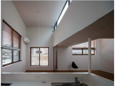
4.15mの高天井にあるハイサイドライトの一部にジャロジーを組み込み、開閉によって部屋の上部に溜まった熱を排出できる仕組みとなっている。春秋の中間期には窓を開放することで、室内に風が抜ける心地良い空間となる。
