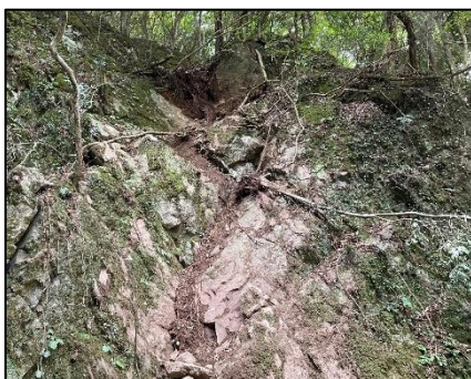
斜面上部の状況
