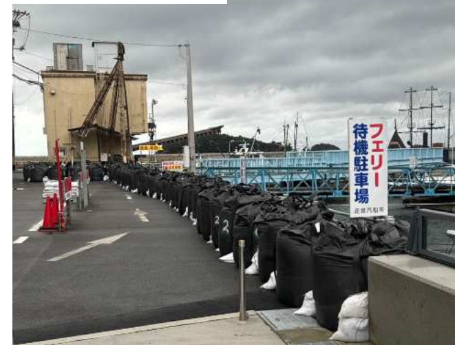
大型土嚢 仮設置
