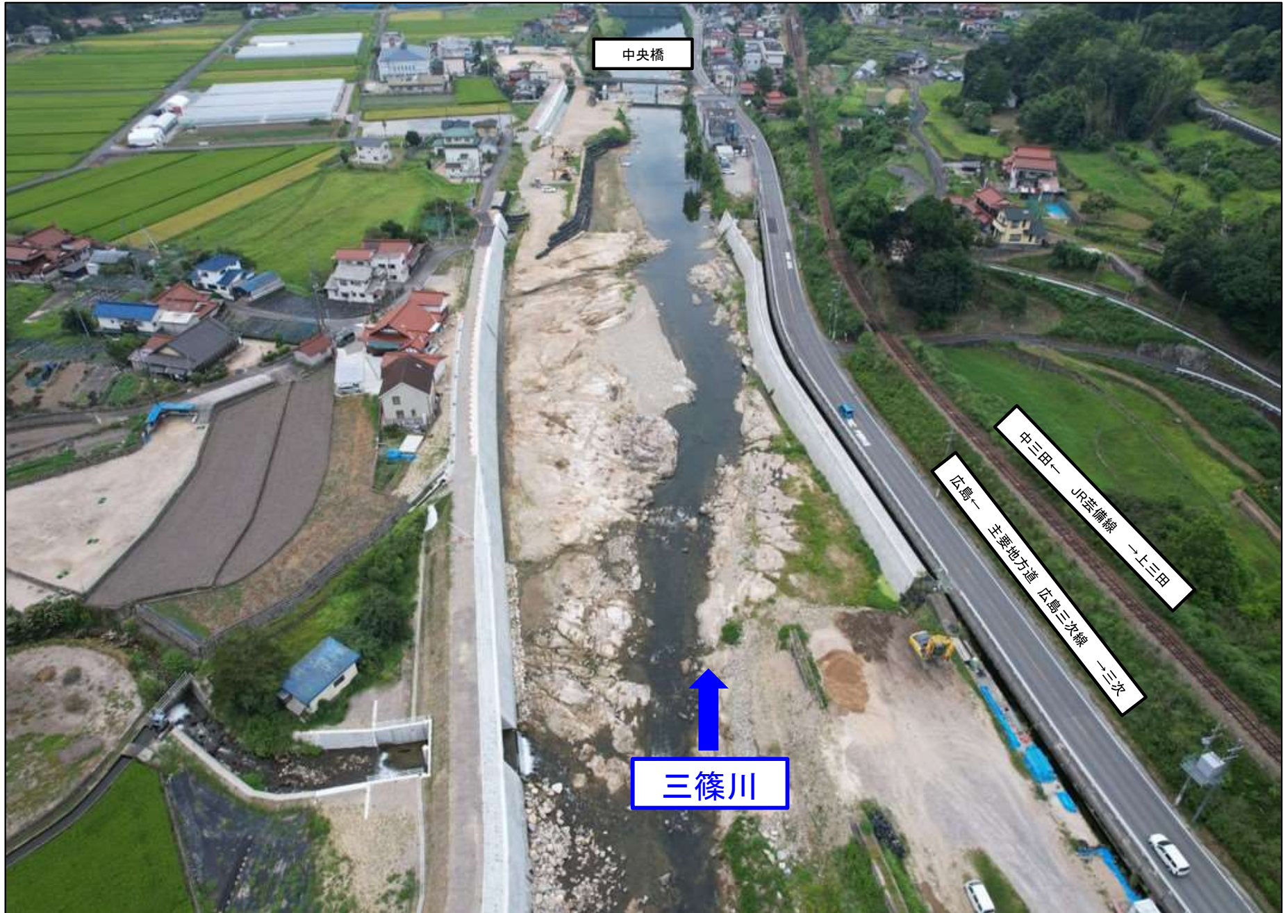
施工箇所付近全景写真（上流側から）
