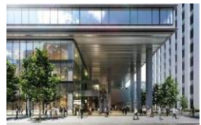
高層棟低層部
