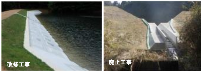
農業用ため池の防災工事
