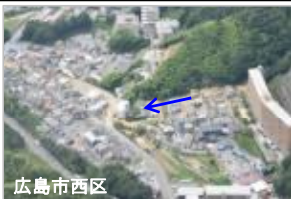
令和3年8月豪雨災害の被災状況
