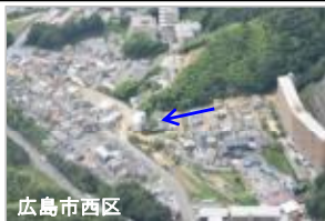
令和3年8月豪雨災害の被災状況
