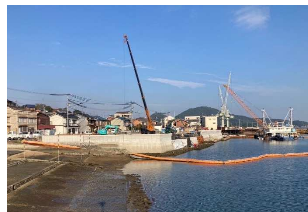
護岸整備状況
