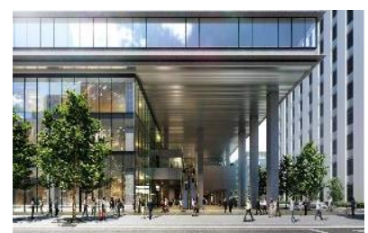
高層棟低層部
