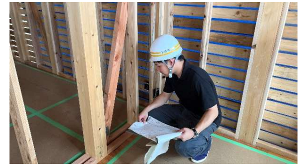
中間検査の様子
