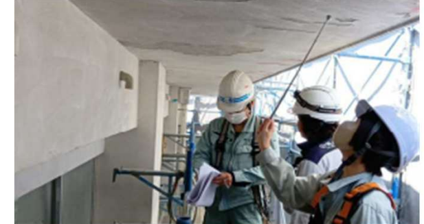
外壁改修工事での調査の様子
