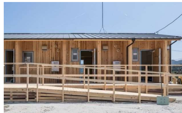
平成30年7月豪雨災害で供給した木造仮設住宅（三原市・あやめが丘応急仮設団地）
