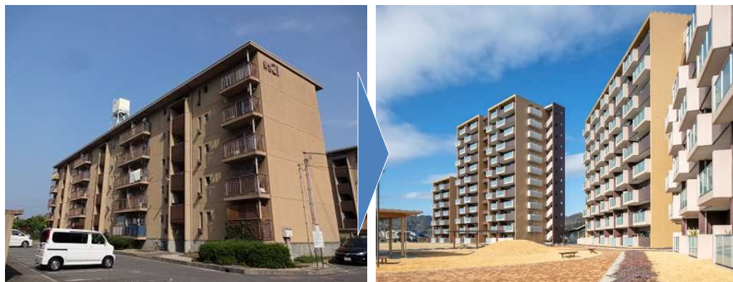
築50年前後経過した住宅（エレベーターなし、風呂なし）を最新の住環境が整った住宅に建て替える。（写真右は県営熊野住宅北ブロック）
