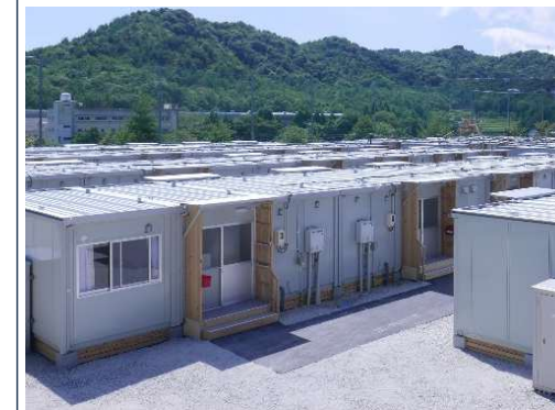
平成30年7月豪雨災害の応急仮設住宅
