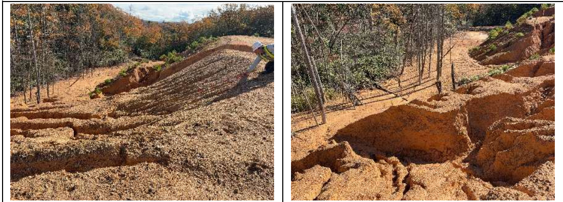
【立入検査時に確認した盛土等の状況】
