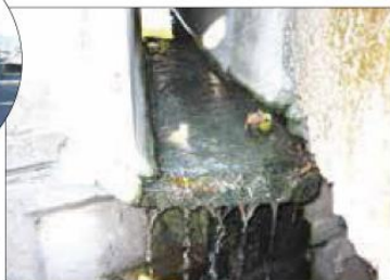
1970年代 単独処理浄化槽設置地域の側溝の例 (白っぽいヘッド口状のものが堆積しています)
