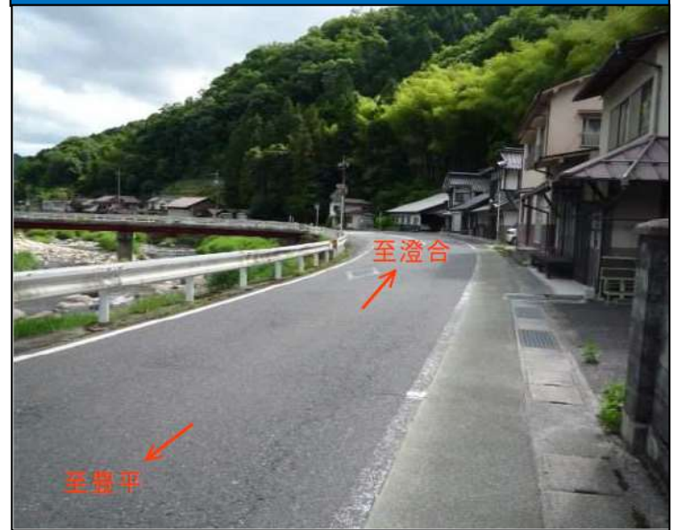
【施工前の状況】
