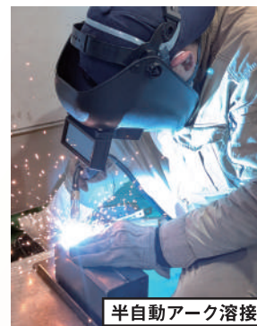
半自動アーク溶接
