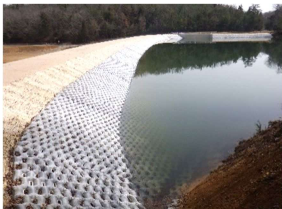
【図7 補強工事(改修)】
