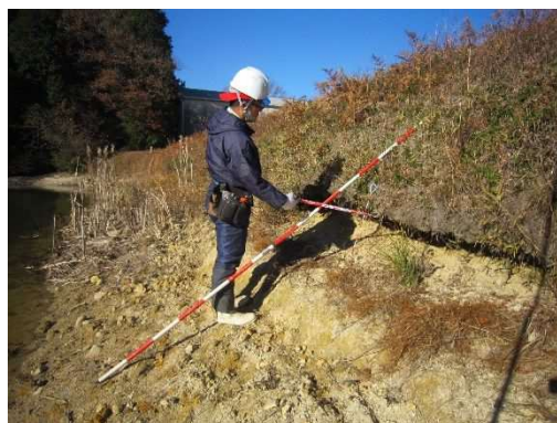
【図2 劣化・豪雨に対する診断の様子】
