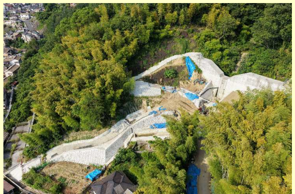
【掘削工(副堰堤部)】
