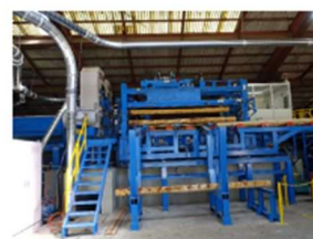
構造用製材工場
