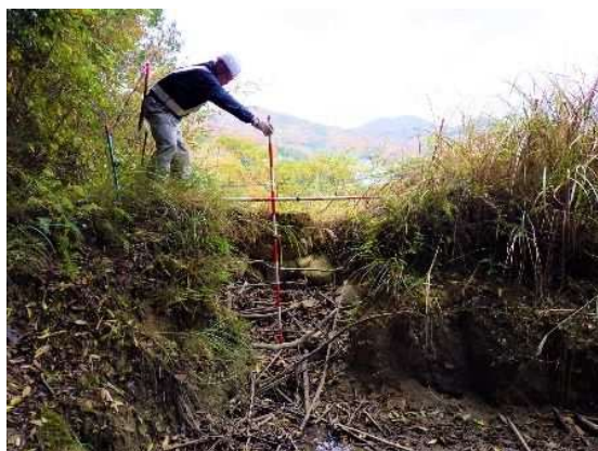
【図9 専門技術者による点検状況】
