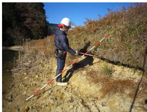
【図2 劣化・豪雨に対する診断の様子】
