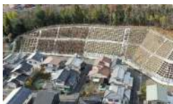
郷5地区【東広島市】 急傾斜地崩壊対策事業
