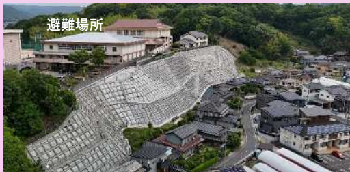
急傾斜地崩壊対策事業（防災拠点等の保全）
