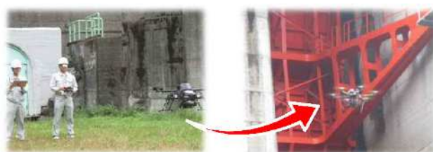
ドローンを活用した施設点検
