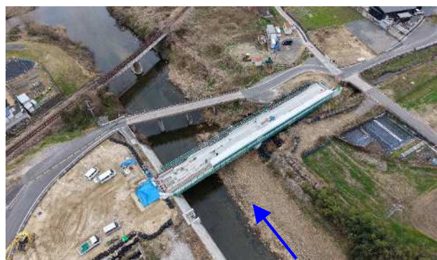
(新) 僧殿橋橋梁上部工事
