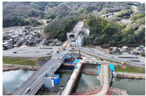
施工状況（草戸町周辺）
