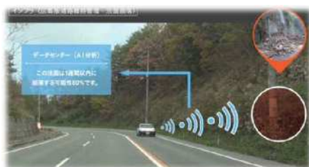
道路法面の崩落予測技術
