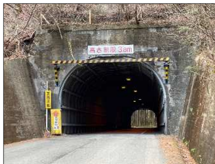
長者原トンネル
