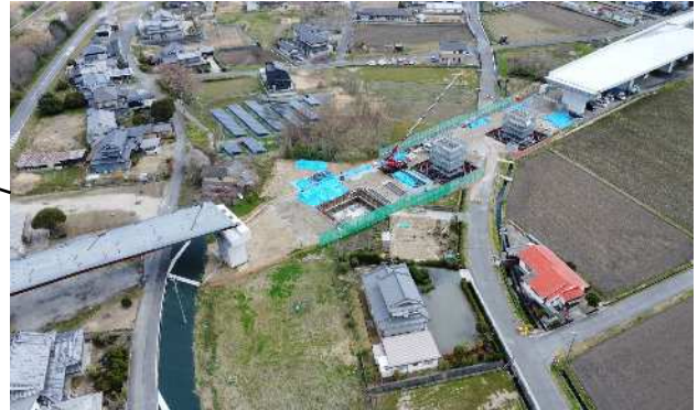
施工状況（福山市駅家町）
