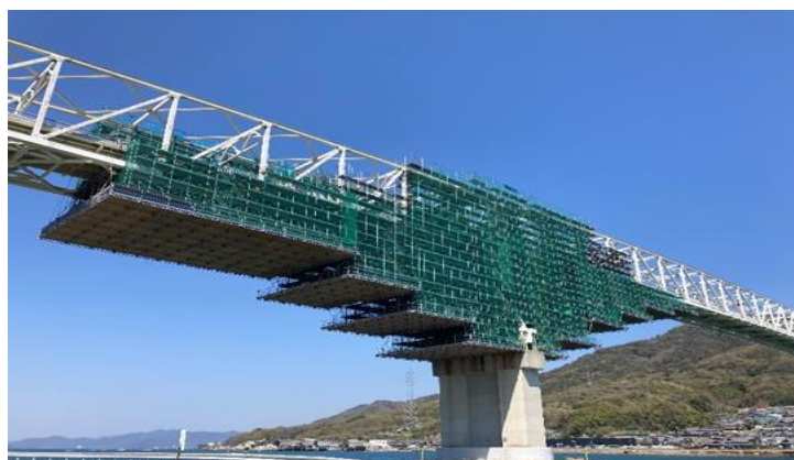
上部工補修・耐震補強施工状況
