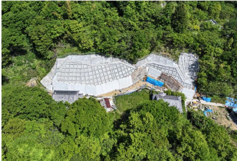
急傾斜地崩壊対策事業 向田地区
