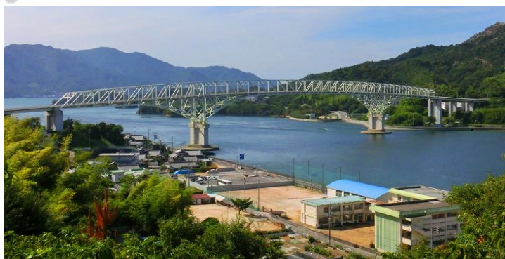
一般国道 487 号 早瀬大橋
