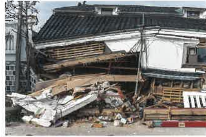
地震による被害例 (能登半島地震)
