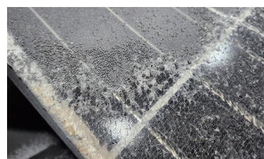
廃棄太陽光パネルからプラスト法によってガラスを除去する様子
