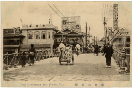
元安橋（東から）
