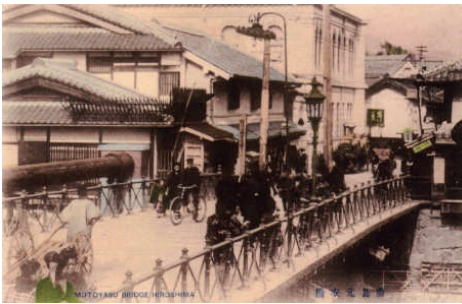
元安橋（南西から）
