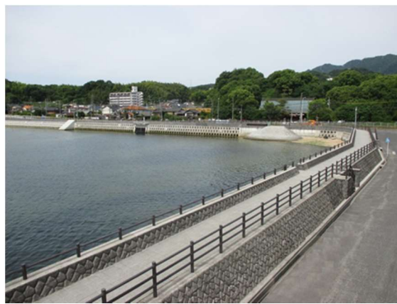
護岸（地御前漁港海岸地御前地区）
