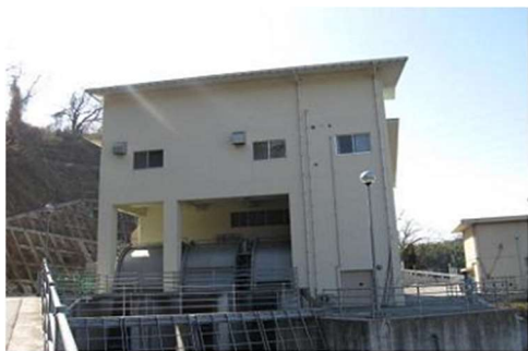
排水機场上屋
