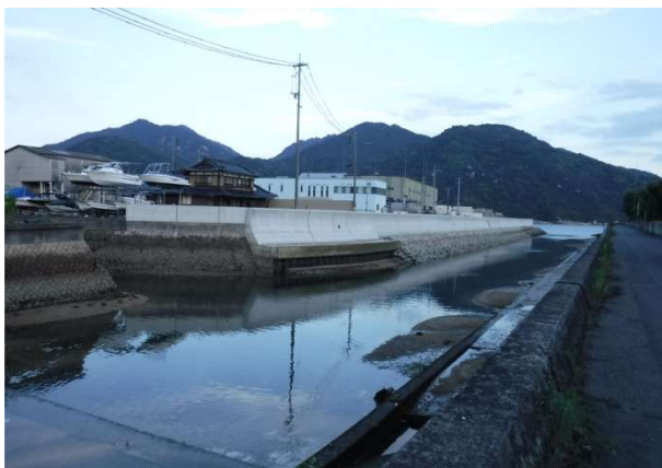
護岸（大野海岸大國蛭ヶ崎地区）
