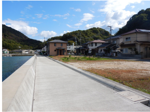
護岸（竹原港海岸的場地区）
