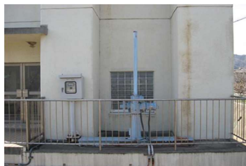
樋門（スルース）
