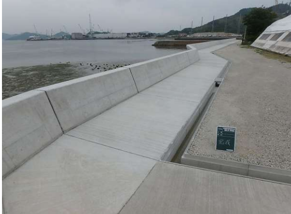
護岸（重井港海岸伊浜東地区）
