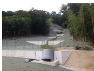
山腹工(土留工)
