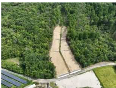
山腹工(東広島市)
