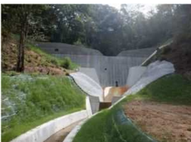
溪間工(谷止工)
