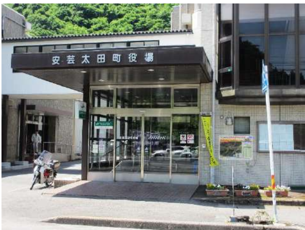
標識設置状況（安芸太田町役場）
