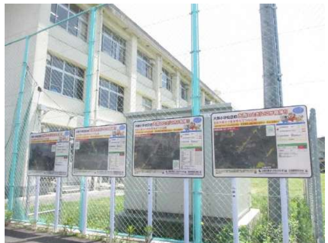
標識設置状況（北広島町立大朝小学校）
