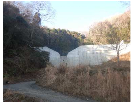
賀茂川支川砂防施設（竹原町東野町）
