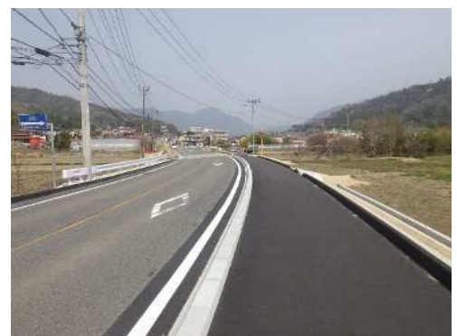
(主) 東広島白木線（東広島市志和町志和東）
