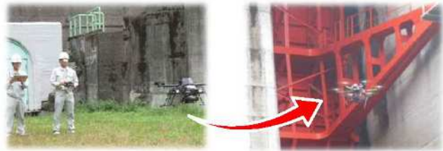
ドローンを活用した施設点検
