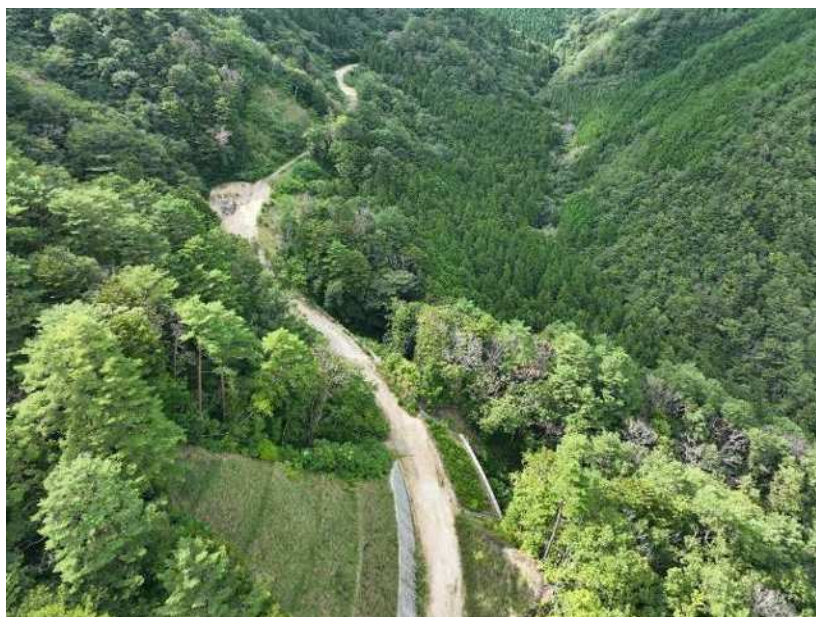
一般国道 488 号の工事状況(廿日市市吉和)
