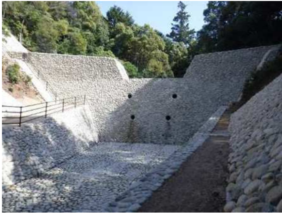
通常砂防事業 樫谷川（廿日市市宮島町） 令和3年度完成
