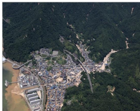
坂町小屋浦の被災状況
