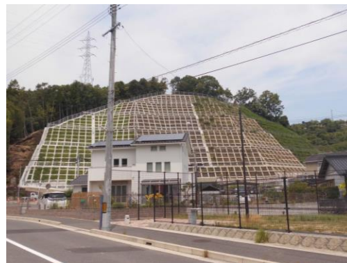
急傾斜地崩壊対策事業の施工例 亀山南二丁目17地区(広島市安佐北区)
