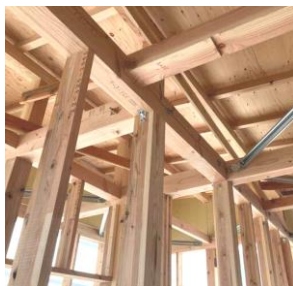
梁・桁、柱への県産スギの利用
