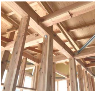
梁・桁、柱への県産スギの利用
