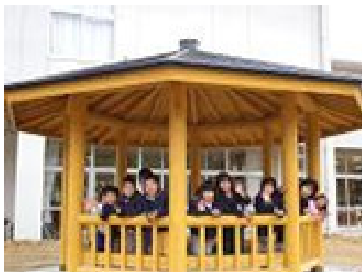
間伐材を利用した東屋の整備 (大崎上島町)
