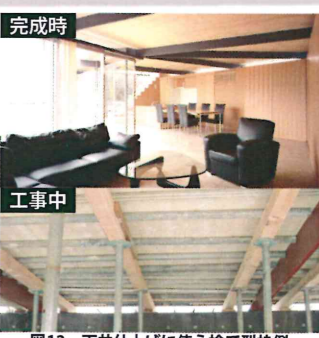
図12. 天井仕上げに使う捨て型枠例
