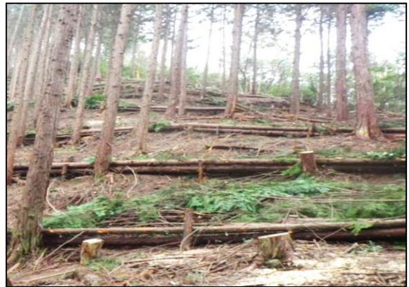
間伐と同時に、間伐木を活用し、表土流亡を防止し林床を安定化させるための木製構造物(筋工)を設置
