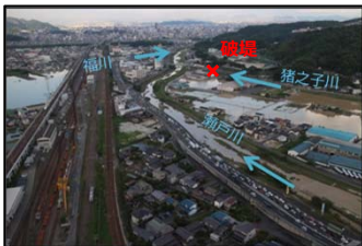
浸水被害状況（瀬戸川流域）
