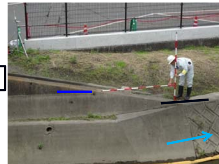
② 排水機場上流
