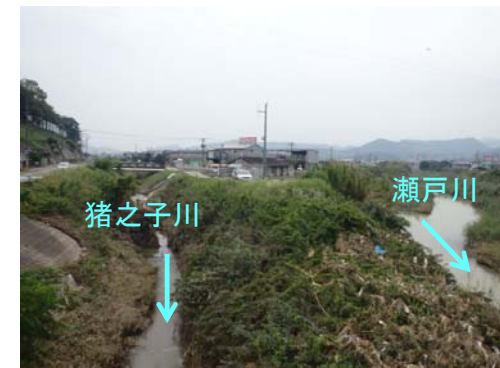
河道内に堆積する土砂 (猪之子川・瀬戸川)
