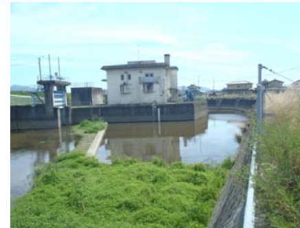
郷分排水機場
