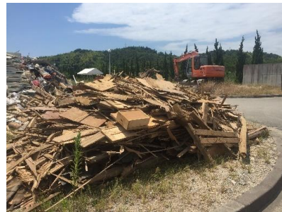
建物解体廃棄物
