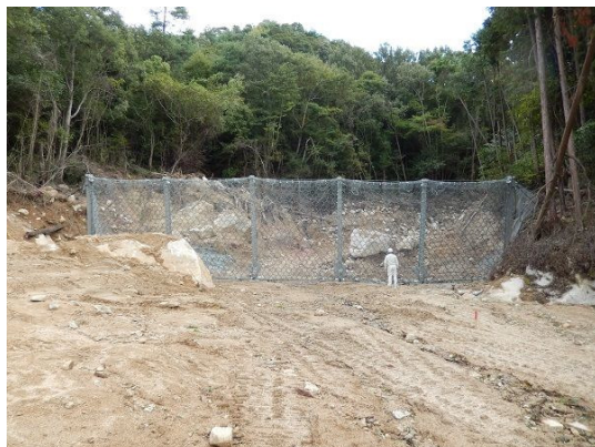
応急対策（ワイヤーネット）の実施（熊野町川角）
