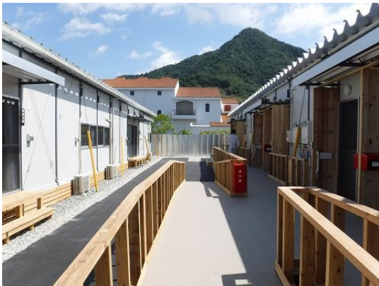
呉市天応応急仮設住宅
