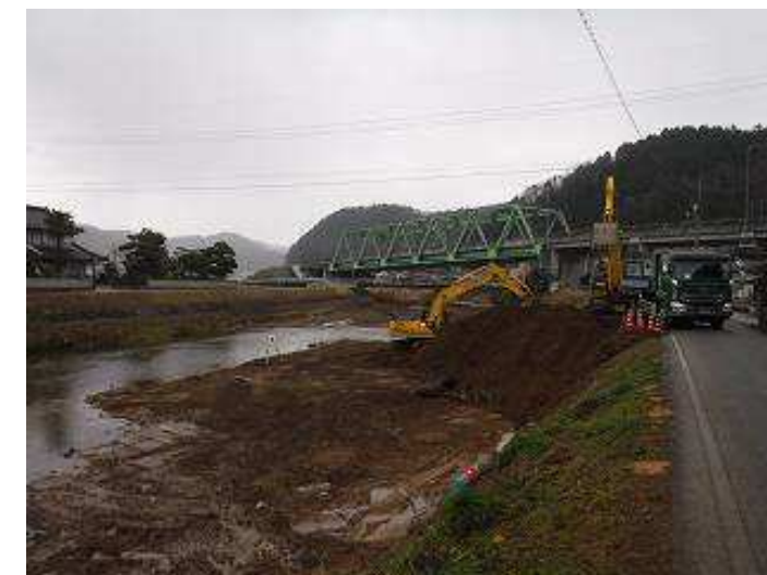
河川 浚渫状況
