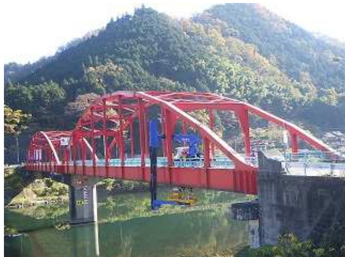
橋梁 点検状況
